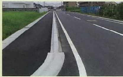
完了日:平成22年3月 製品名:ベース付歩車道境界ブロック 津市役所 神納南河路1号線 津市神納町
