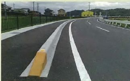
完了日:平成22年3月 製品名:ベース付歩車道境界ブロック 松阪建設事務所 辻原西町線 松阪市笹川町
