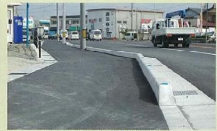
完了日:平成21年12月 製品名:L型街渠ブロック 松阪建設事務所 一般地方道鳥羽松阪線 松阪市豊原町
