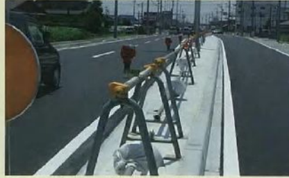
完了日:平成22年7月 製品名:ベース付中央分離帯ブロック(オリジナル) 一宮建設事務所 道路改良工事 岩倉市
