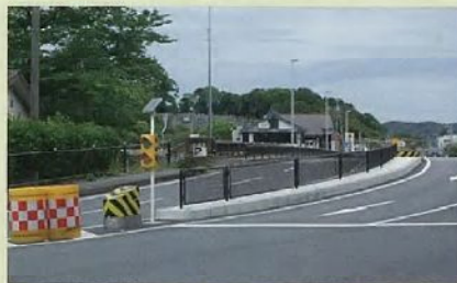
完了日:平成21年12月 製品名:歩車道境界ブロック 伊勢建設事務所 主要地方道伊勢磯辺線 伊勢市勢田町
