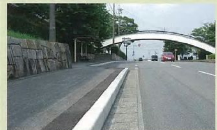
完了日:平成21年12月 製品名:SR-L 桑名建設事務所 一般県道桑名東員線 (防草対策工)東員町大字山田
