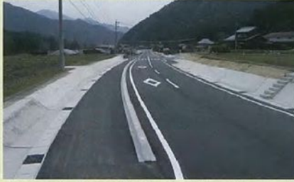
完了日:平成22年2月 製品名:ベース付歩車道境界ブロック 松阪建設事務所 通狭線 飯高町宮本
