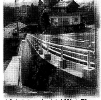
ジオテキスタイル補強土壁
