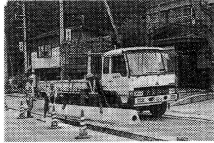
布設作業 特殊ジョイントで容易に接続できます。
