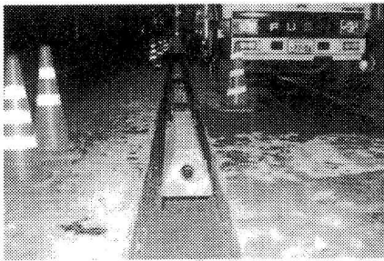
ブロック布設状況
